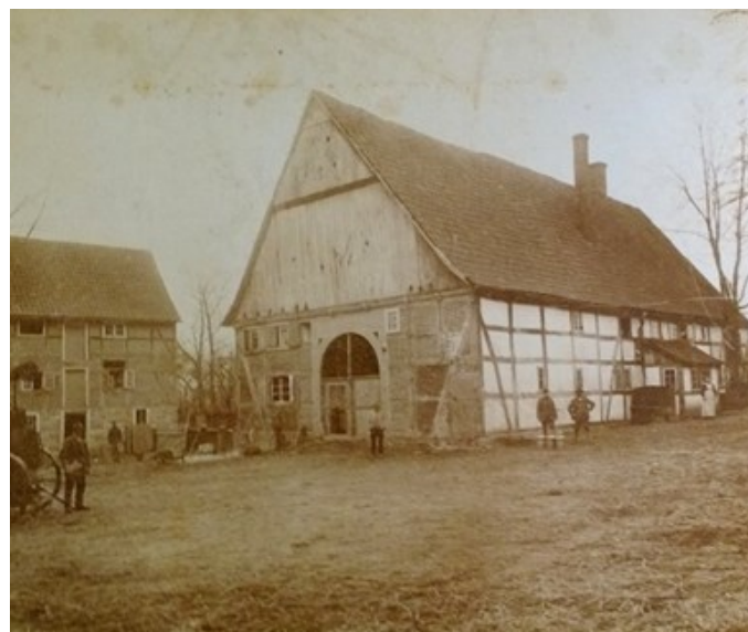
Hof mit altem Wohnhaus, 1890
